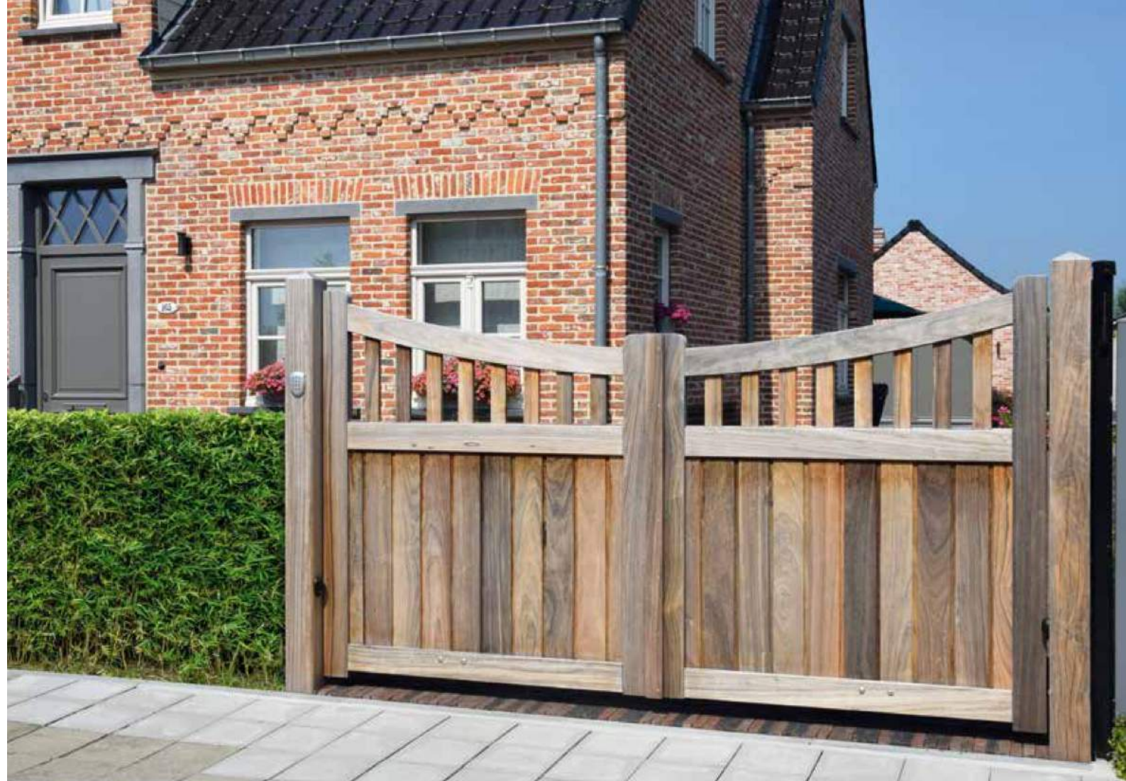
180/160 x 300 cm padouck - ici planches à tenon et mortaise
